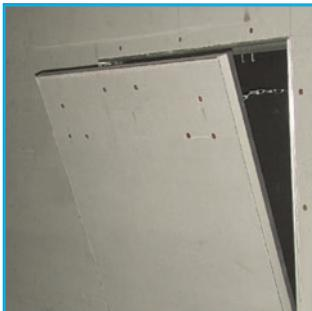
Ревизионные люки АКВАПАНЕЛЬ® с возможностью установки в конструкции перегородок, облицовок, стен шахт и подвесных потолков.
